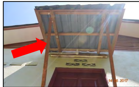
Rumah PBR Kg. Durian Bador, Hulu Terengganu - Awning Dicat Tidak Sempurna (14.06.2017)
