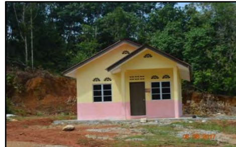
Rumah PBR Kg. Peris, Hulu Terengganu - Rumah Siap Tiada Bekalan Elektrik (TNB) (06.06.2017)
