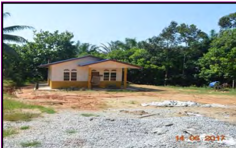
Rumah PBR Kg. Sekayu, Hulu Terengganu - Rumah Siap Tiada Bekalan Elektrik (TNB) (14.06.2017)
