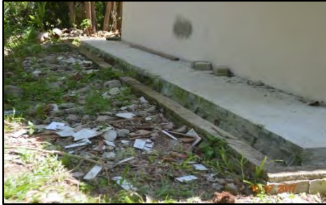
Rumah PBR Kg. Pak Wong, Besut - Kemasan Longkang Tidak Sempurna (10.07.2017)
