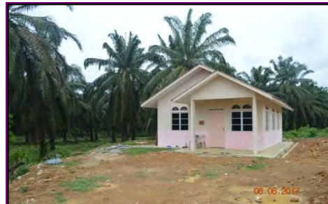
Rumah PBR Kg. Sungai Siput, Hulu Terengganu - Rumah Siap Tiada Bekalan Elektrik (TNB) (06.06.2017)
