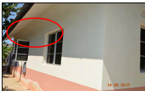
Rumah PBR Kg. Matang, Hulu Terengganu - Lubang Angin Tidak Dibuat (14.06.2017)
