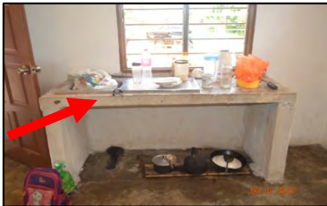
Rumah PBR Kg. Bukit Layat, Setiu - Pemasangan Mوزek pada Kabinet Dapur Tidak Dilaksanakan (06.07.2017)
