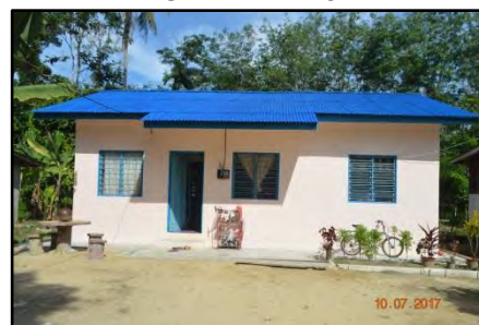
Rumah PBR Kg. Tok Dor, Besut - Lubang Angin Tidak Dipasang (10.07.2017)
