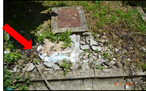
Rumah PBR Kg. Kerandang, Besut - Sisa Binaan Tidak Dibersihkan (10.07.2017)
