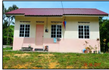
Rumah PBR Kg. Bukit Ara, Hulu Terengganu - Binaan Mengikut Pelan Diluluskan (Pandangan Hadapan) (06.06.2017)
