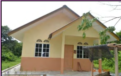
Rumah PBR Kg. Bukit Diman, Hulu Terengganu - Rumah Siap Tiada Bekalan Elektrik (TNB) (06.06.2017)
