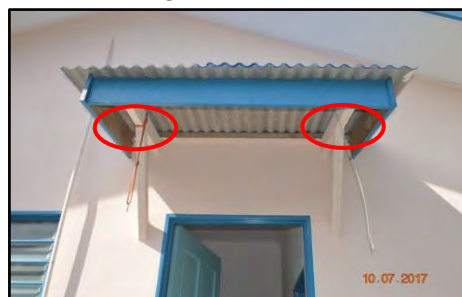
Rumah PBR Kg. Tok Dor, Besut - Awning Tidak Dicat Dengan Sempurna (10.07.2017)
