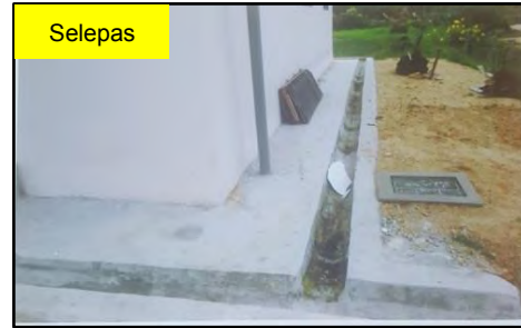
Rumah PBR Kg. Gong Kepas, Besut - Pemasangan Manhole Telah Dilaksanakan (24.08.2017)
